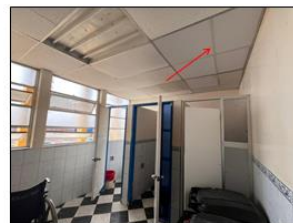
Corrección del techo falso (cielo raso)
